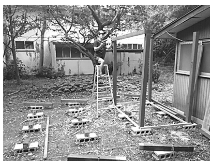
ウッドデッキを作るスタッフ
